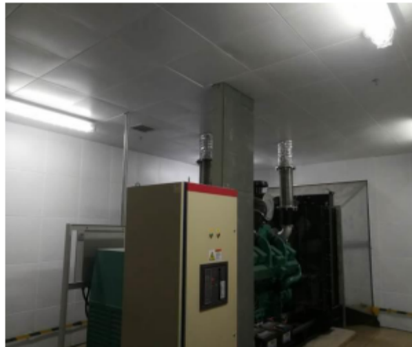
发电机独立烟囱管道及减震垫
